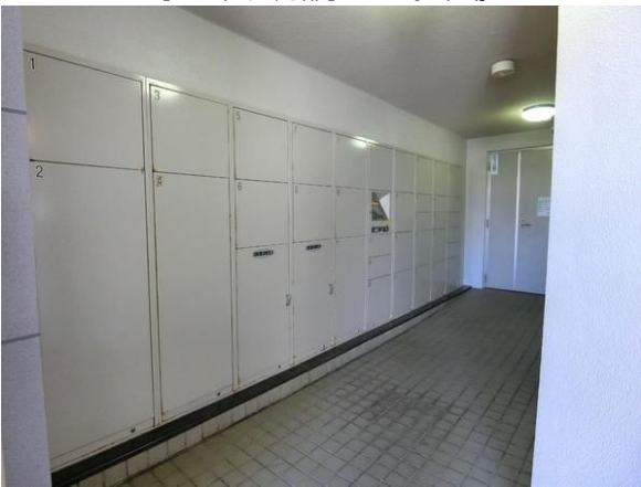
【宅配ボックス】
