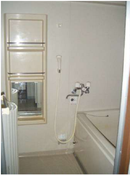
【浴室】H29年浴槽交換
