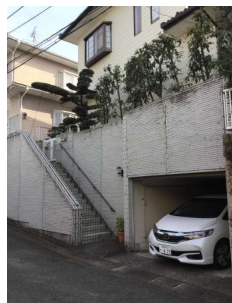
【現況外観写真】
