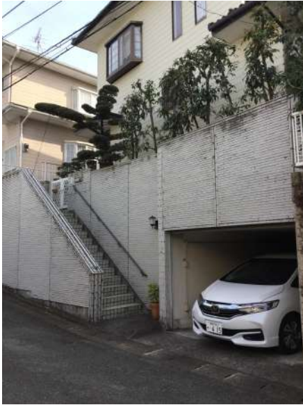
【現況外観写真】
