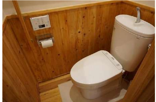
【トイレ】トイレ
