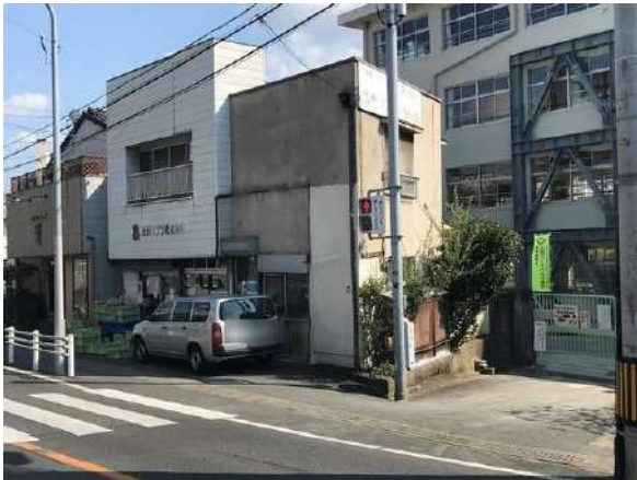
【外観写真】外観
