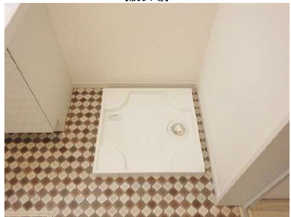
【脱衣場】洗濯機パン
