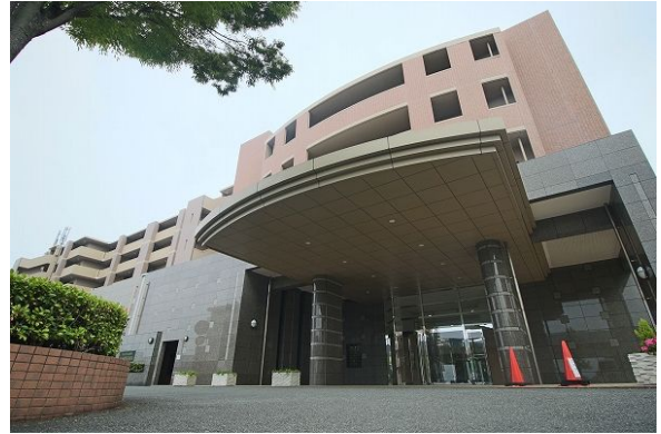
【外観写真】オートロック、防犯カメラ付き。
