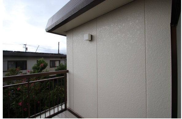
【外観写真】外壁塗装済みです
