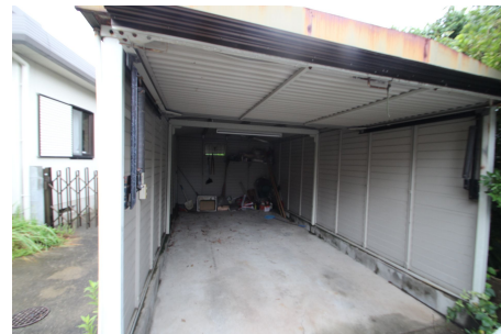
【駐車場】1台はガレージタイプ(他は屋根なし)
