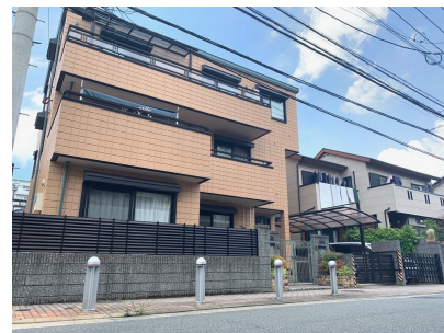
2016年に外壁塗装をしてあり、外観もキレイです。
